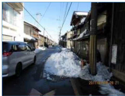
屋根等が崩落し、県道片側を閉塞する様子（H29年1月）
